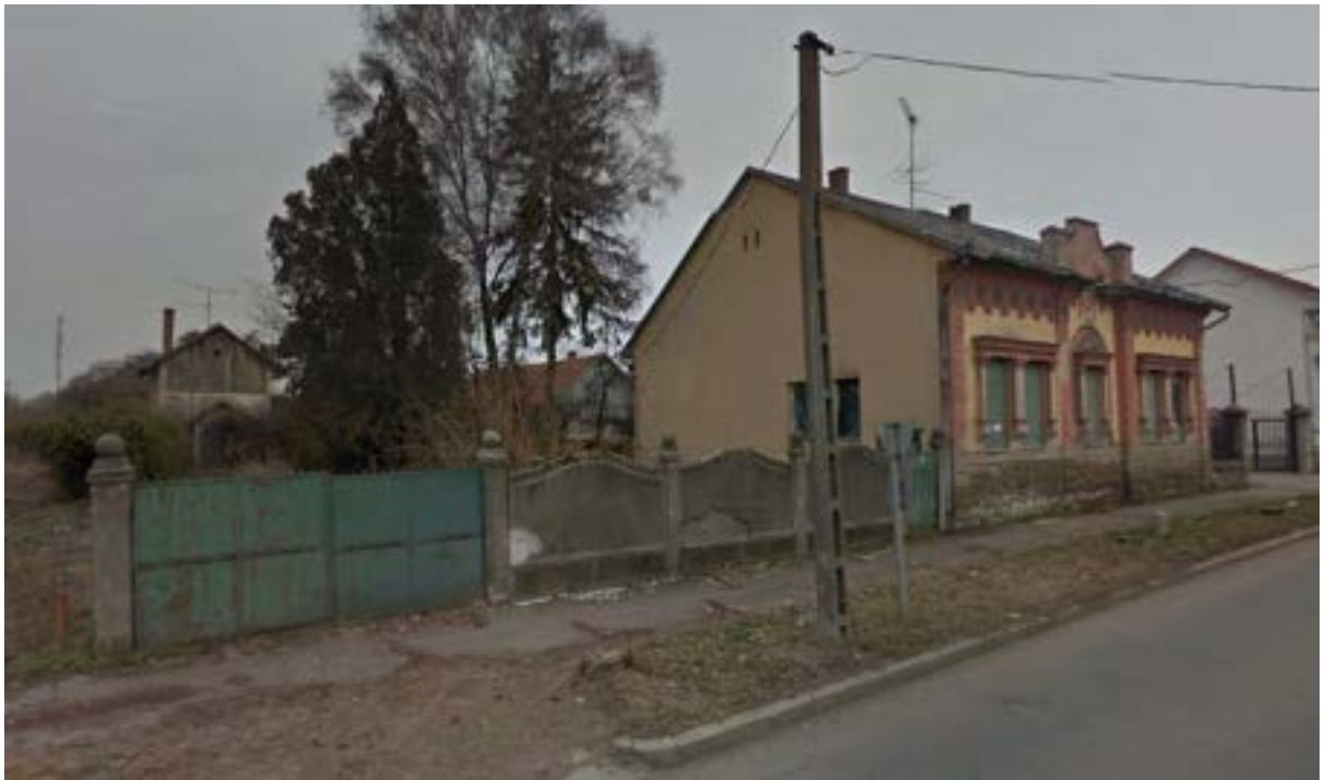
F03 | Az épület északkelet felől (2012)
